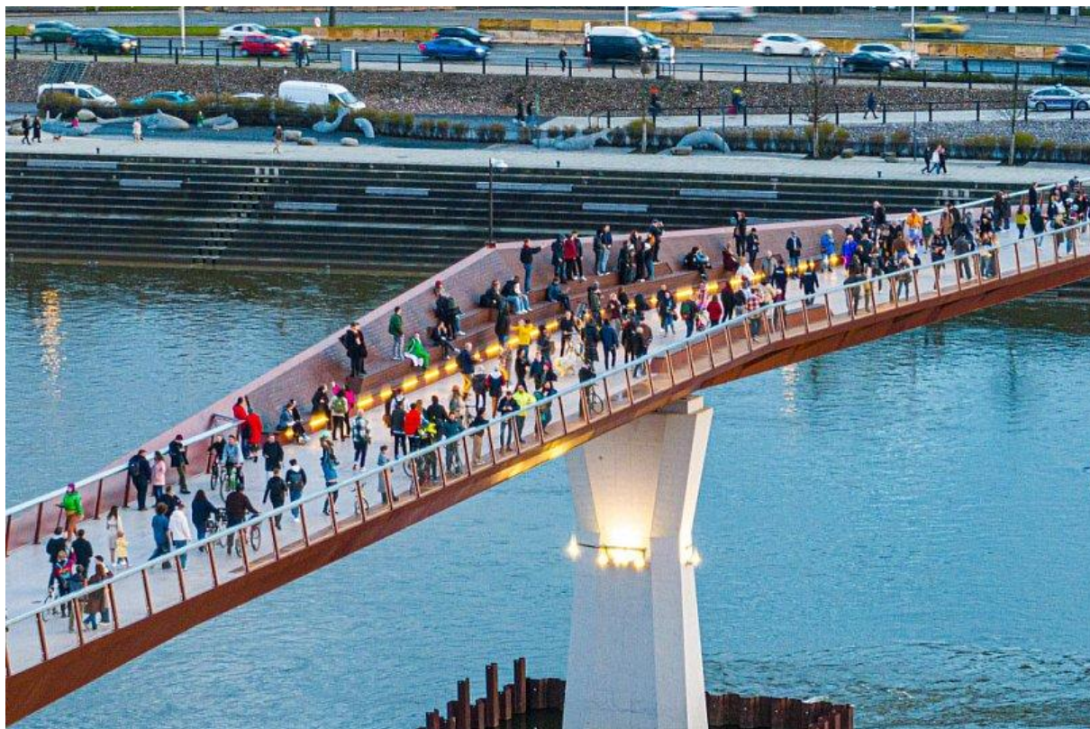
Fotografia 5.5 Kładka pieszo-rowerowa na Ursynowie w Warszawie
