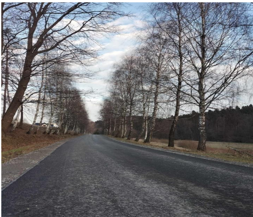
Przebudowa drogi gminnej we współpracy z Lasami Państwowymi - nawierzchnia asfaltowa dz. nr 1553 w m. Lecka.
